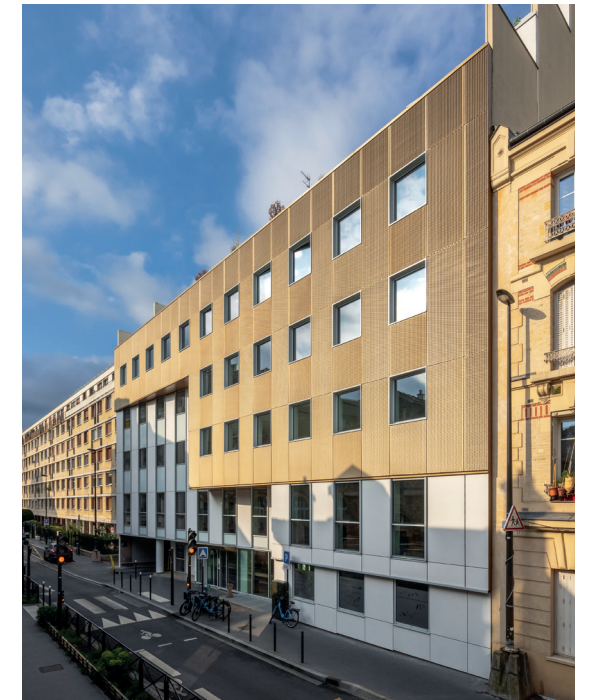
Les Patios A, sis 86-88 rue Thiers à Boulogne-Billancourt, restructuré en 2022.
